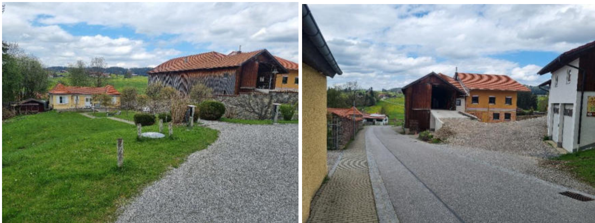
Abbildung 10: linkes Bild Bereich geplanter Neubau, rechtes Bild Schlossstraße Bereich Einfahrt Nord mit Bergeinlauf Sinkkasten
