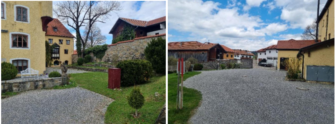
Abbildung 9: linkes Bild Bestand Schloss von Südosten, rechtes Bild Einfahrt Nord
